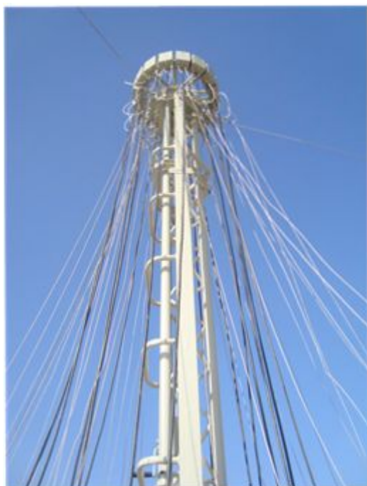
Многолучевая АФС-16V «Зонт» (перед подъемом)
