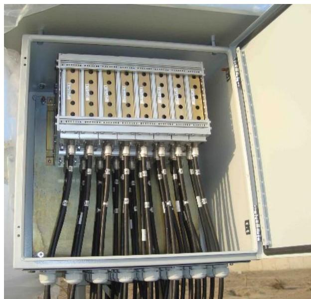
Блок магистральных ШАУ многолучевой АФС-16V «Зонт»
