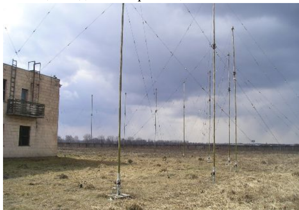
Общий вид объекта размещения РПС «Р-700М»
