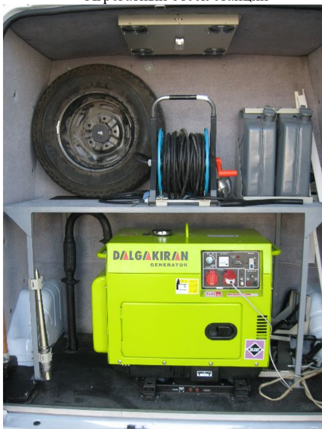
Агрегатный отсек станции
